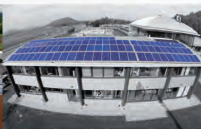
Wanty : Installation de 159 kWc, soit 636 panneaux
