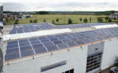
Devillers : Installation de 50 kWc, soit 200 panneaux
